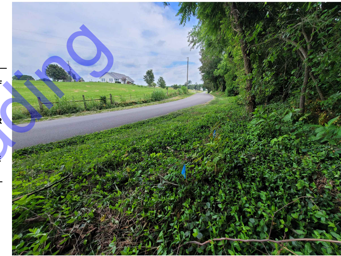
METER 17: NEW METER FACING SE
